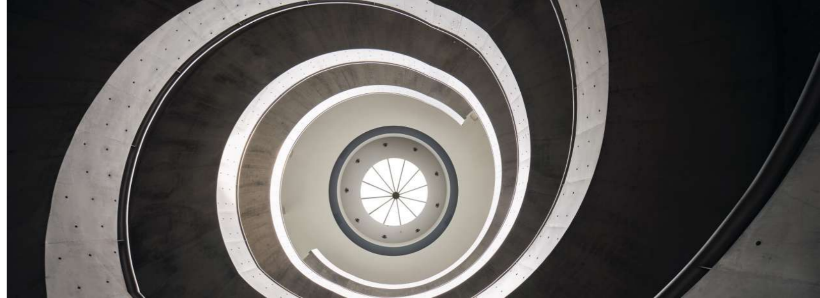
和美术馆清水混凝土双螺旋楼梯 和美术馆
